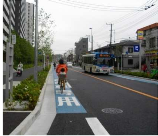
しんかわさき きたかせ おくら 新川崎地区 市道北加瀬60号・小倉18号線 (神奈川県川崎市)
